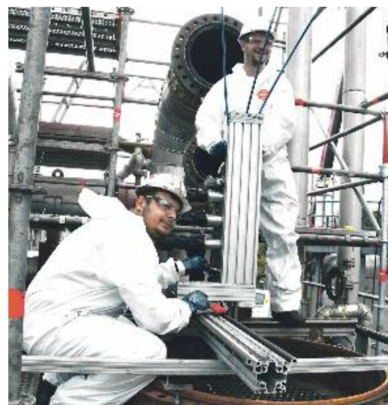
Lobbe-Mitarbeiter bauen die „Robotized Lance Frame“ (RLF) auf. Diese technische Lösung entwickelte das Unternehmen selbst, um Wärmetauscher vollständig automatisiert zu reinigen. (Foto: Lobbe)
