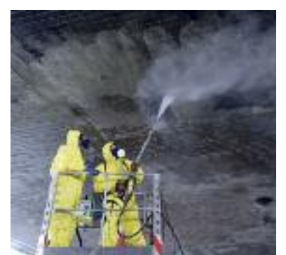
Lobbe-Mitarbeiter bei der Reinigung der A59-Brücke (Foto: Lobbe)
