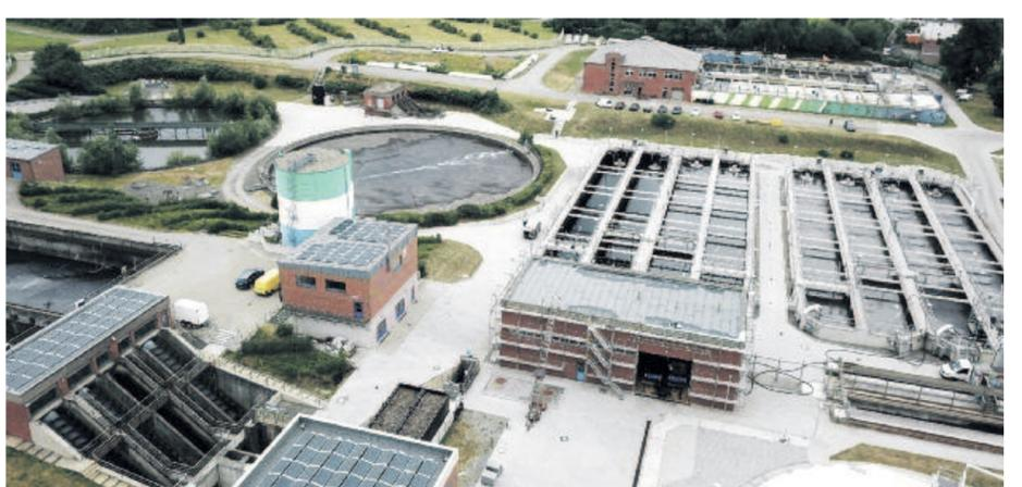
An der Kläranlage Huckingen wird die neue Anlage die Wärme aus dem Abwasser für das Fernwärmenetz nutzbar machen. (Foto: DVV)
