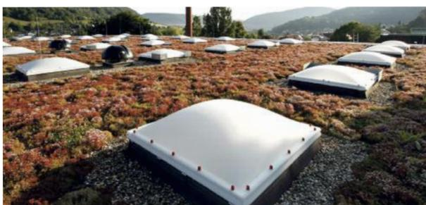
Das Dach einer Sporthalle in Baden-Württemberg ist mit Lichtkuppeln aus Voerde ausgestattet. So ist ein begrüntes Dach möglich, das zugleich viel Tageslicht ins Innere lässt.
