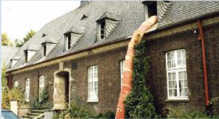
Der historische Eingang wird heute noch für Hochzeitsempfänge genutzt. Im zuvor ungenutzten Obergeschoss entstanden Seminarräume.
