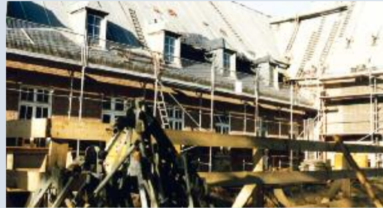
Hier entstand gerade das Fundament für den Glasgang, der heute Foyer und Auditorium entlang der Terrasse miteinander verbindet.
