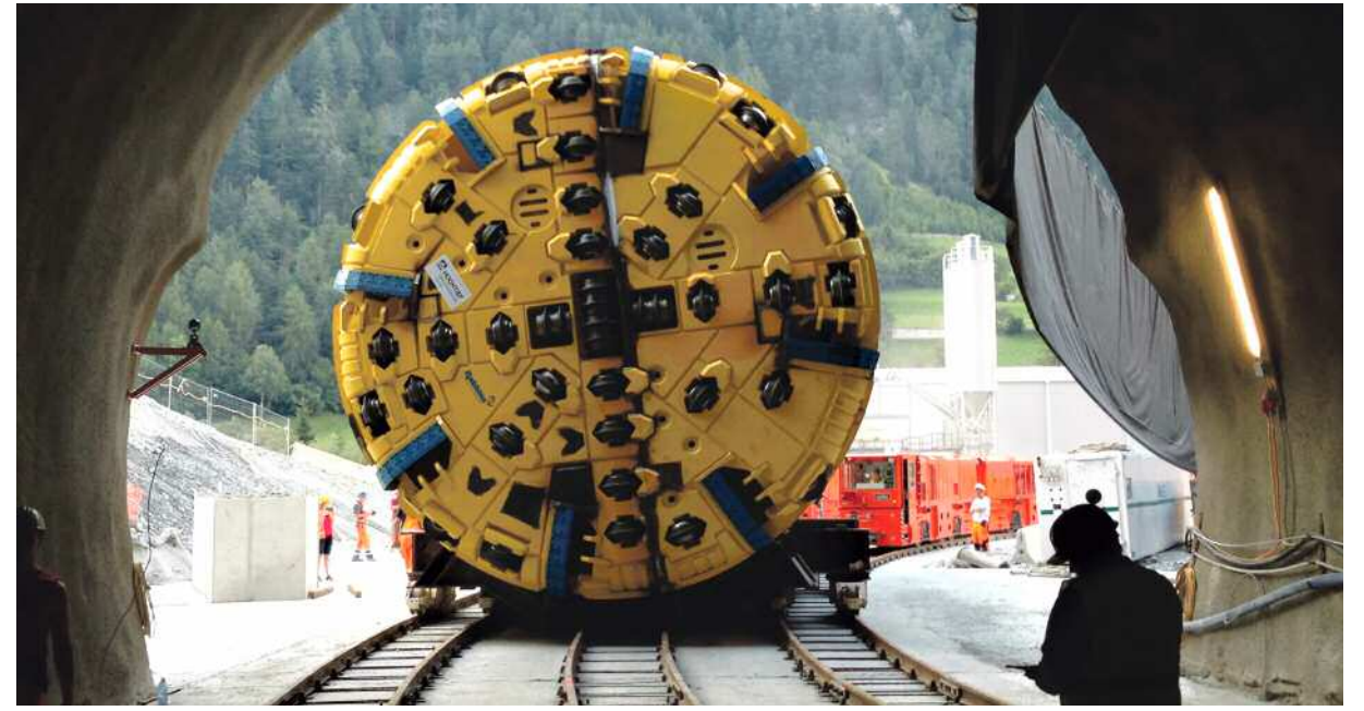
Eine Tunnelbohrmaschine fährt in den Tunnel des schweiz-österreichischen Gemeinschaftskraftwerks ein; die Gleissysteme hat das voestalpine Rail Center in Duisburg gefertigt. (Foto: voestalpine)
